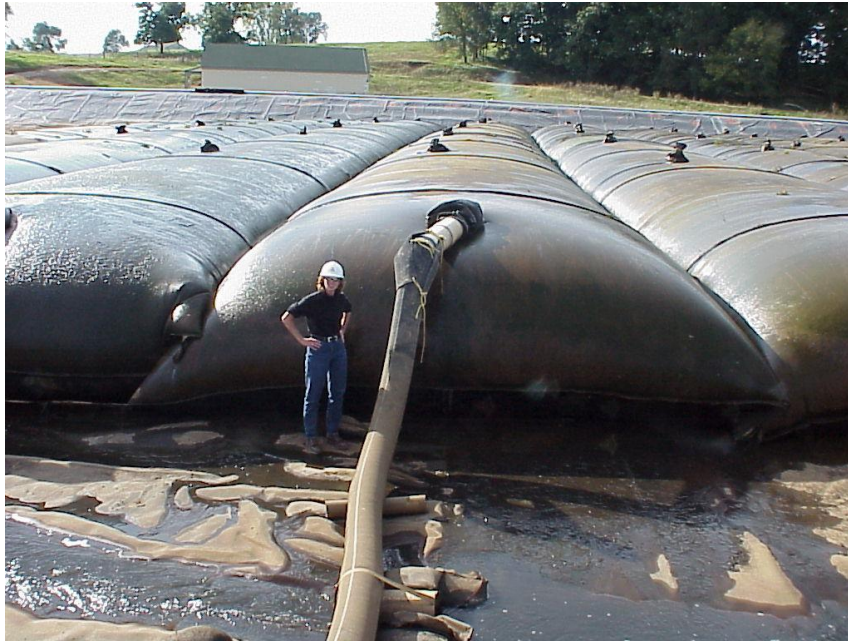
Foto 1 Geotubide täitmine ladestusplatsil
